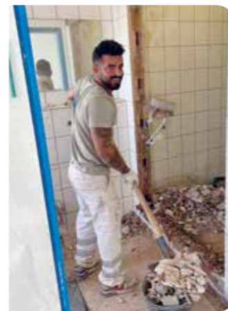
8 Abbruch und anschliessend Aufbau der neuen Dusche in der Damenumkleide
