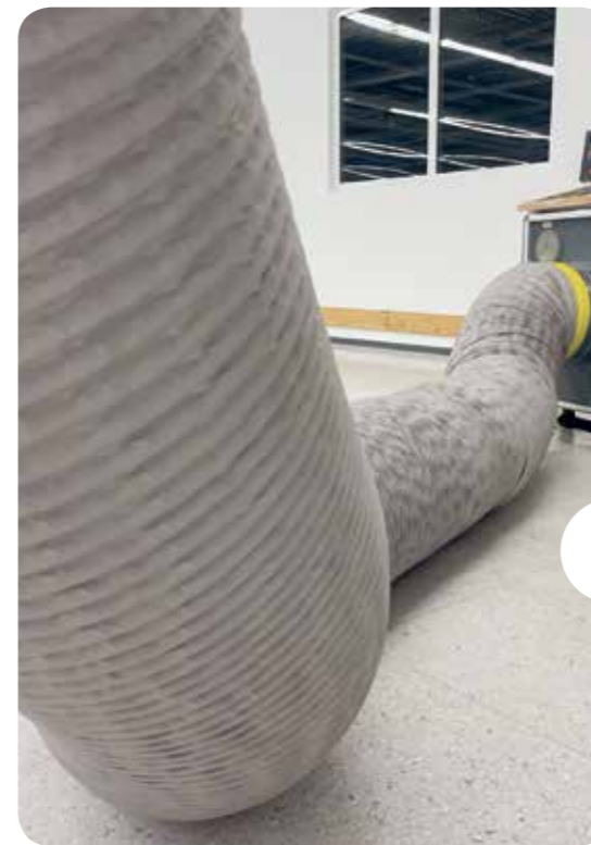
5 Reinigung der gesamten Lüftungsanlage (ca. 1800 Meter Rohre) von innen
